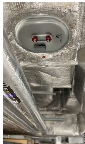
Capteur permettant le monitoring de l'état d'empoussièrement d'un réseau de soufflage qui asservit une ZAC.
